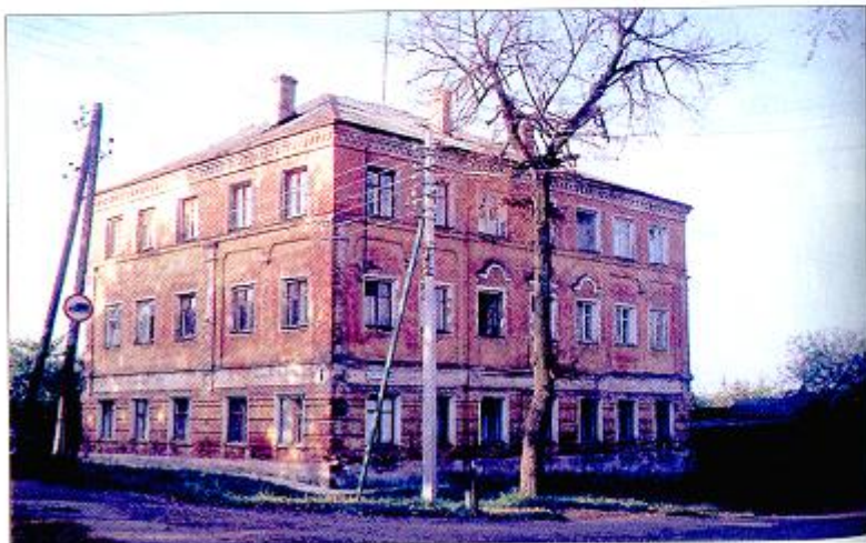
Бывший дом купца И. Ф. Руднева на ул. Введенской (ныне ул. Энгельса) в Кашире
