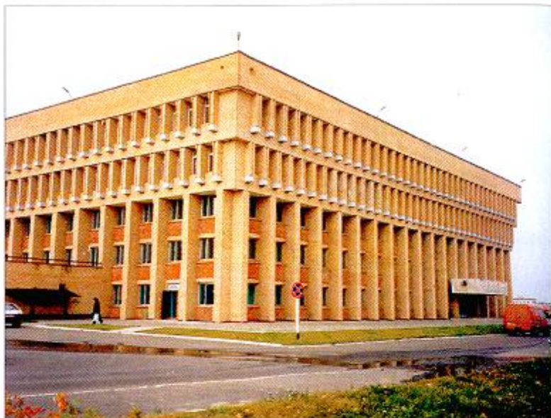
Административное здание муниципального объединения «Каширский район»
