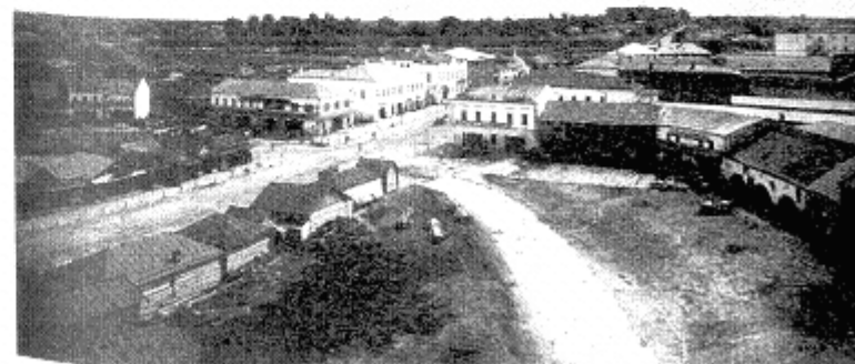
Кашира. Вид с южной стороны. Фото начала XX в. Из собрания Каширского краеведческого музея
