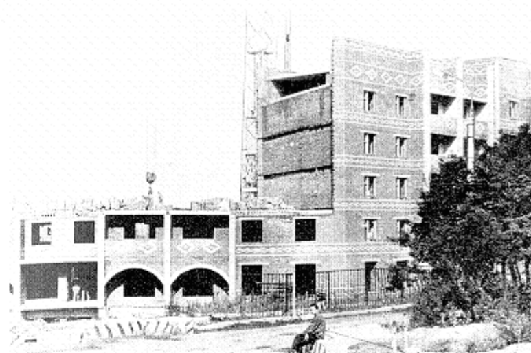
Строят новый дом. Кашира-2. 1995 г. Фото В. В. Лебедева
